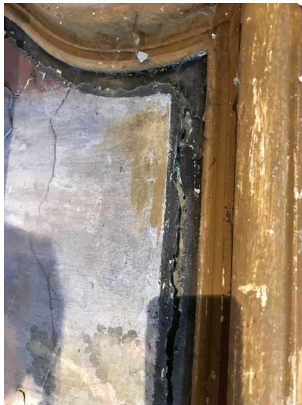
Détail de l'angle supérieur avec un fragment totalement décollé. Un repeint jaune figure à l'angle.
