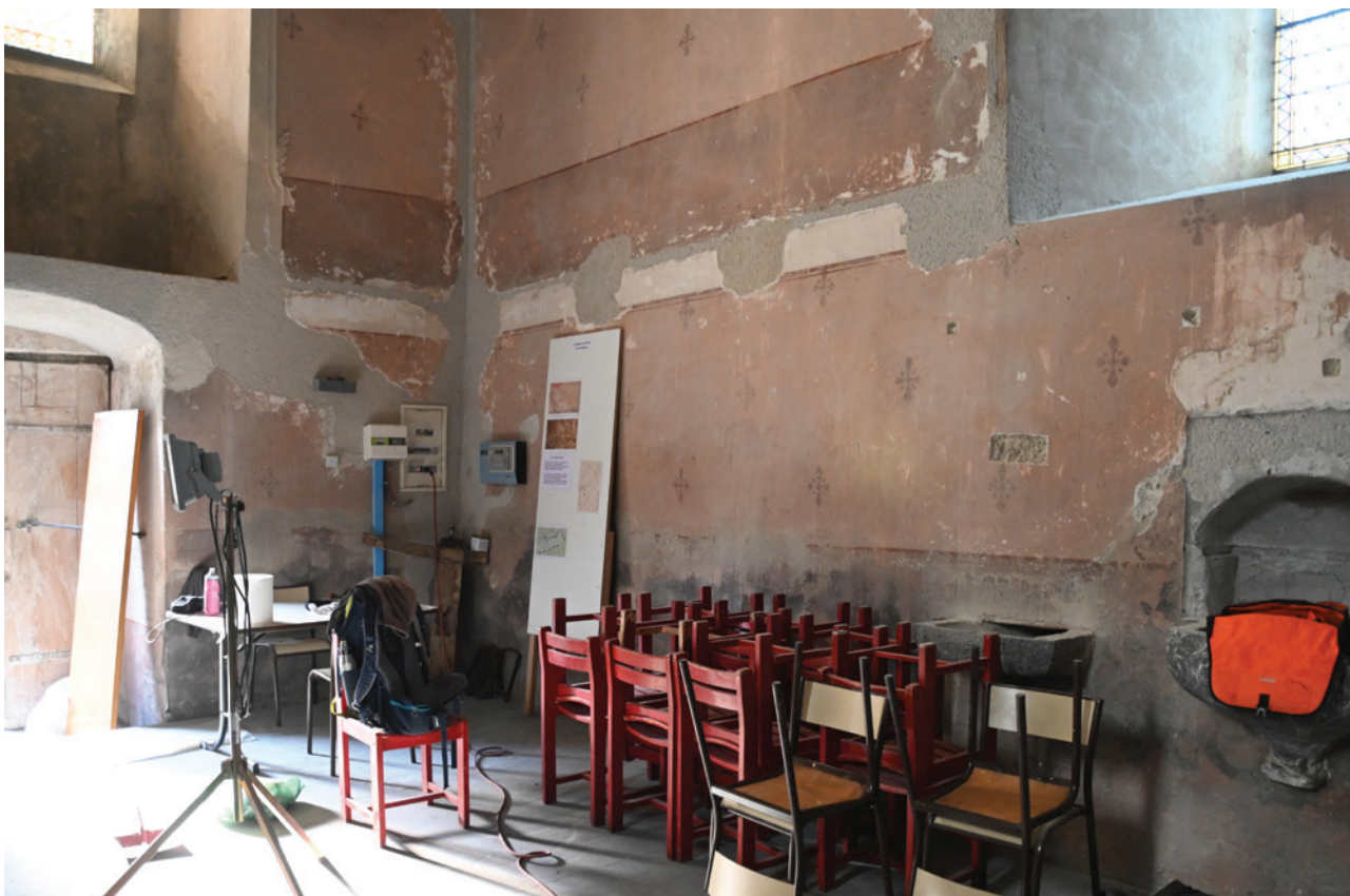
Vue d'ensemble du décor de badigeons au niveau de la tribune.
