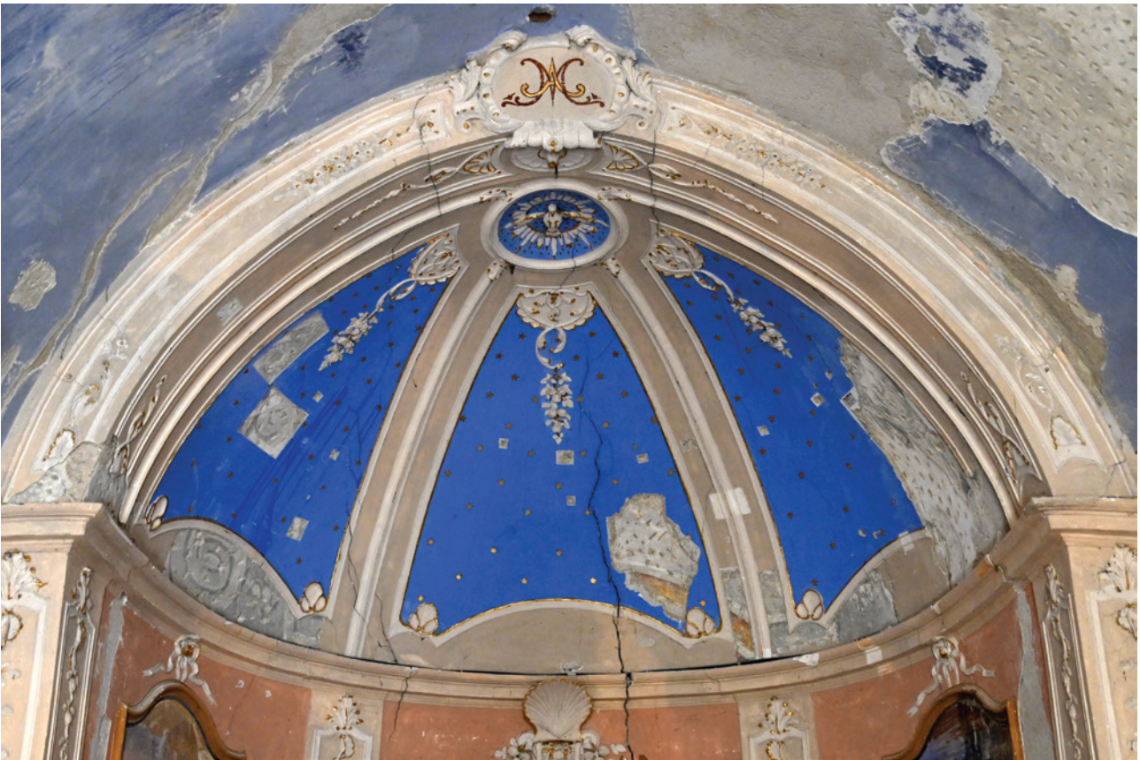
Vue générale des sondages en voûte
