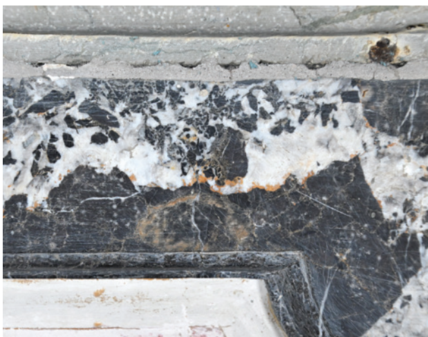
Détail de la pierre polie en face avant, le bloc a été choisi intentionnellement et placé sur la face pour la présence de traces d'oxyde jaune qui ponctuent le veinage.
