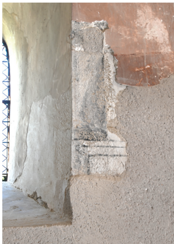
Baie 2 - Sondage N°10, base du pilier droit.
