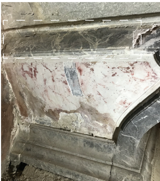
Photos ci-dessus: Pièces sur les côtés (traverses) reconstituées en stuc marbre.
