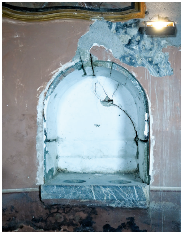
Lavabo ou piscine liturgique au sud, avec un décor peint similaire à celui de la niche au nord.
