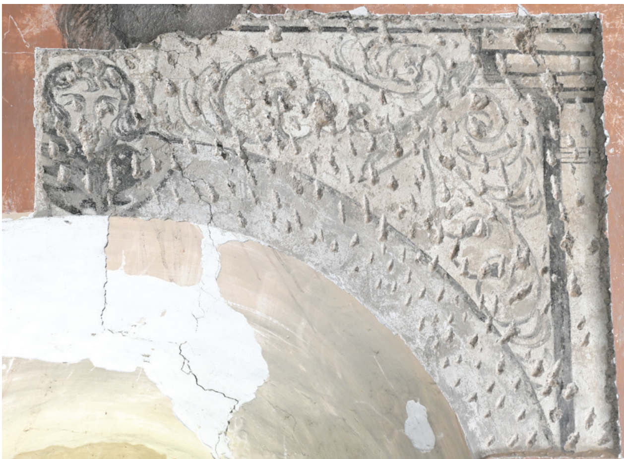
Baie 2 - Sondage N°6
