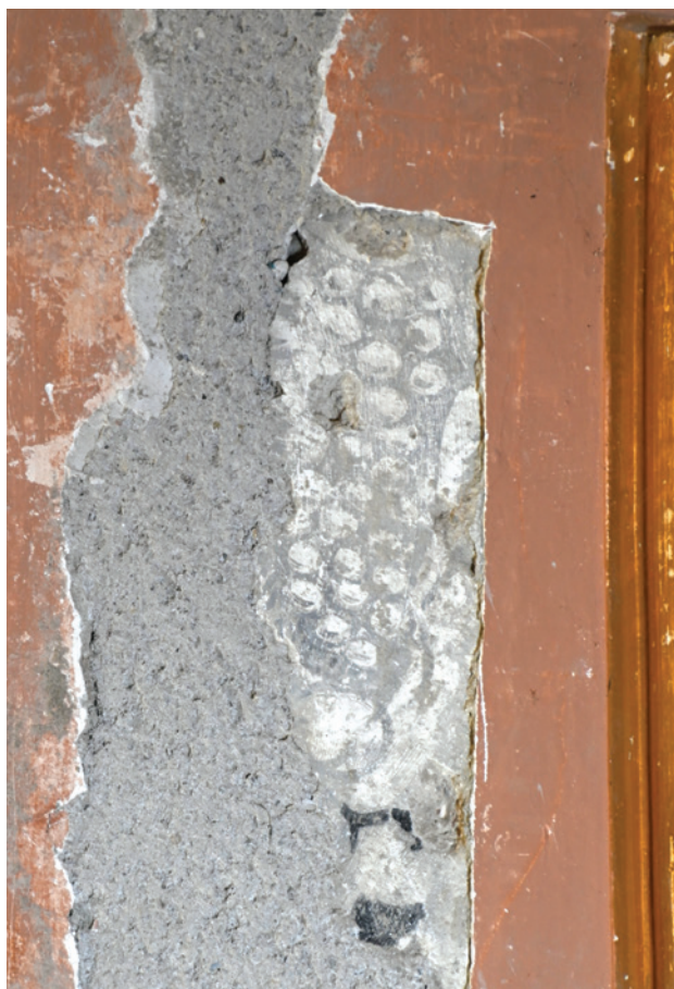
Sondage N° 11, élévation nord - chute de fruits détail de pampre
