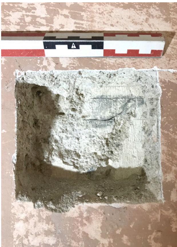
Sondage N° 2, Moulure en doucine du chapiteau à gauche
