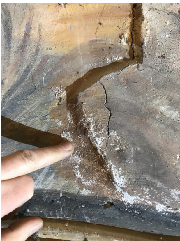
Détail du colmatage au plâtre à la base de la peinture et repeint.
