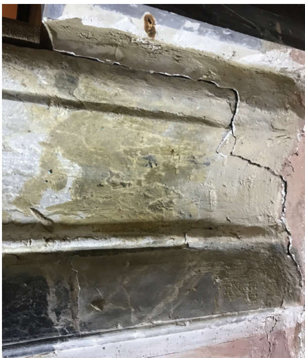
Assemblage grossier, côté droit, fissuration du plâtre, tâches (colle jaunie?).
