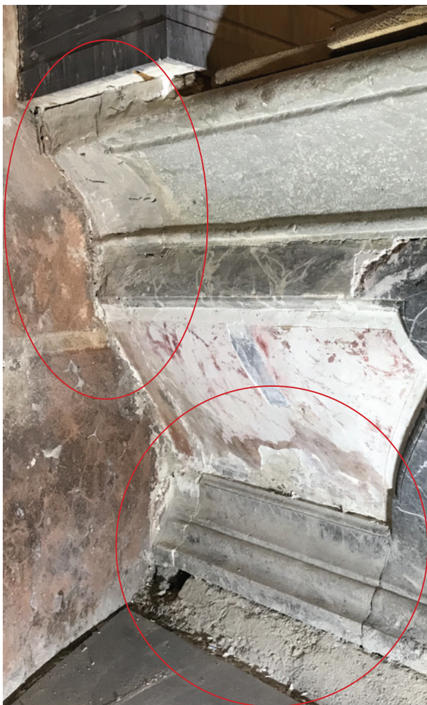
Assemblage grossier, côté droit, fissuration du plâtre, tâches (colle jaunie?).
